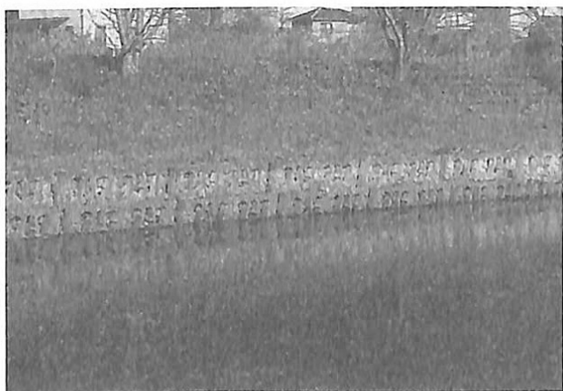
挿絵⑤ 護岸工事
