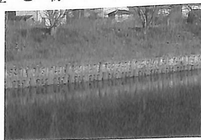
水生生物に優しい護岸工事
