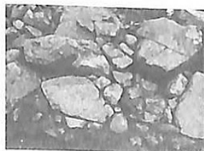
石垣および間積み石の近景
