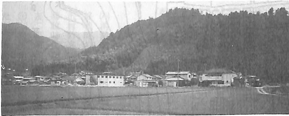
中さつき遠景 西側より
